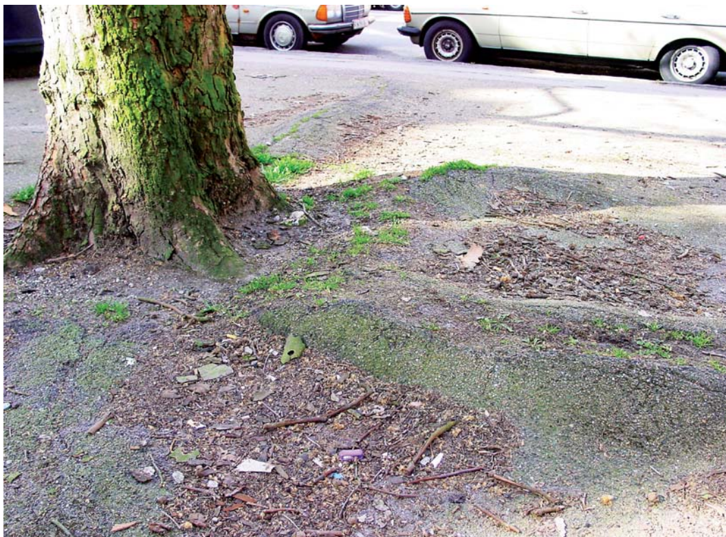
Der er lagt asfalt helt ind til stammen på denne platan, og regnvandet løber derfor i kloakken i stedet for at komme træet til gode. Arealet muliggør faktisk en stor åben plantegrube med stor nedsivning af regnvand. Den kunne let erstatte asfalten som rødderne alligevel ødelægger.
