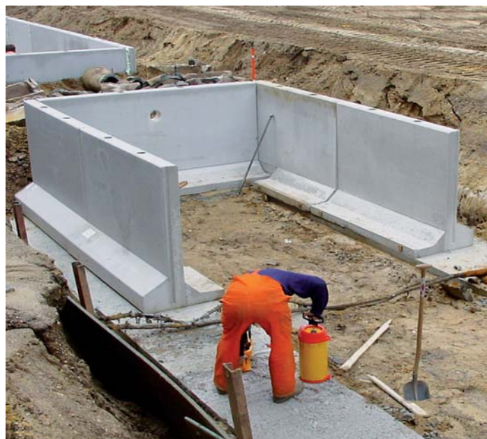
En 'træbunker' fra Holland. Sider og låg er af beton. Foto: CROW.
